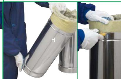
**3** Colocar la junta en su alojamiento en la pared interior de la parte M para DN 80-130 o en la H si se trata de los diámetros superiores.
