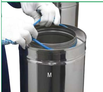
**3** Lubricar en el exterior de la pared interna de la parte H (DN 80 -130). Diámetros superiores en la cara interna de la pared interior de M.
